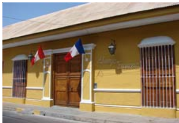
▲ Façade de l'Af de Piura
